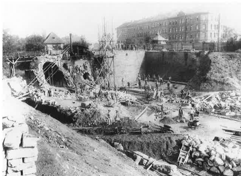
Bild 1. Abbruch der Stadtbefestigung im Zuge des Baus des Flutgrabens sowie der Krämpfertorbrücke um 1895
