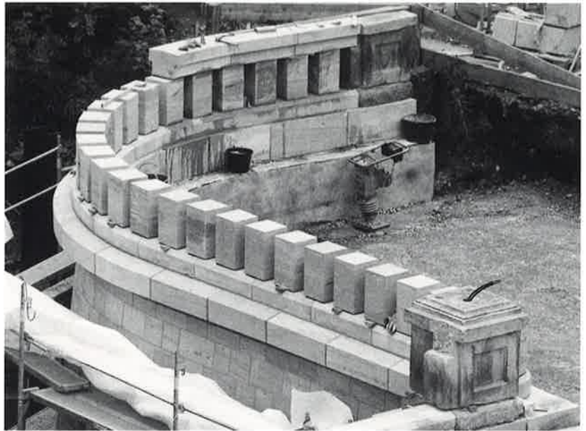
Bild 10. Flügel nordost – Natursteinarbeiten an der Brüstung Fig. 10. North-eastern wing – natural stone work on the balustrade
